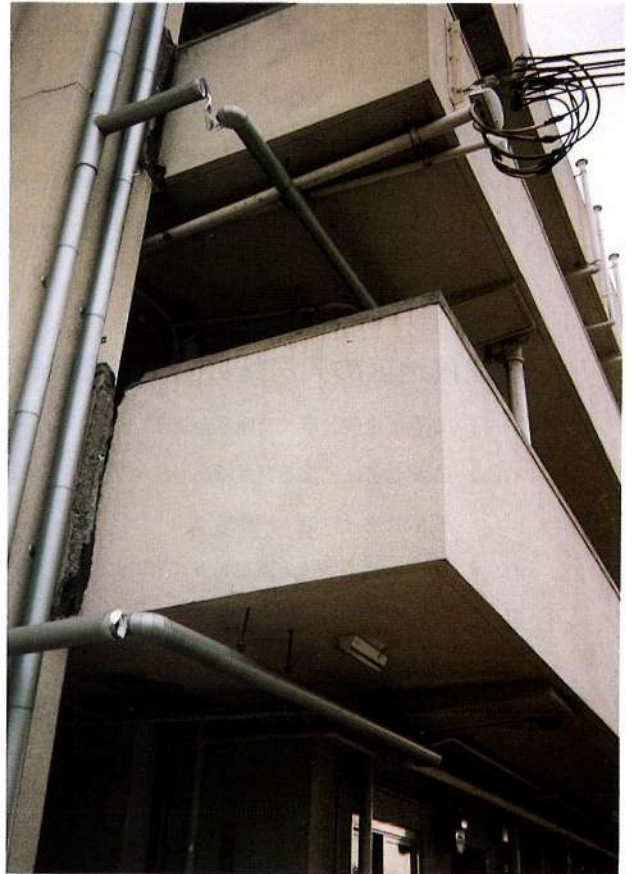
改良した給水管の破断 写真(100)
