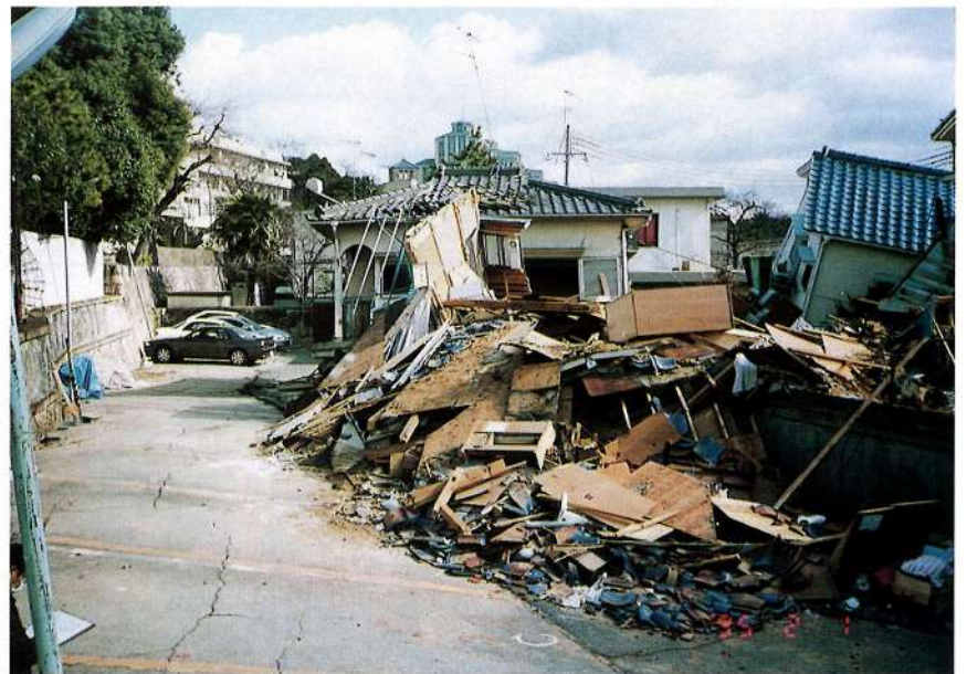
隣接戸建て住宅の崩壊
