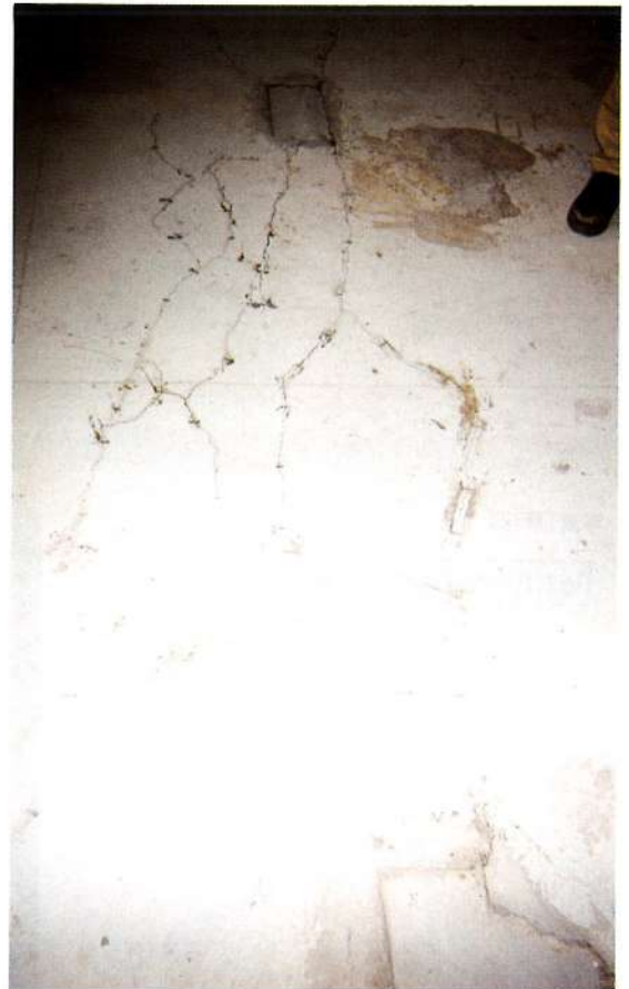
写真(芦-25) 住戸内床スラブの補修後
