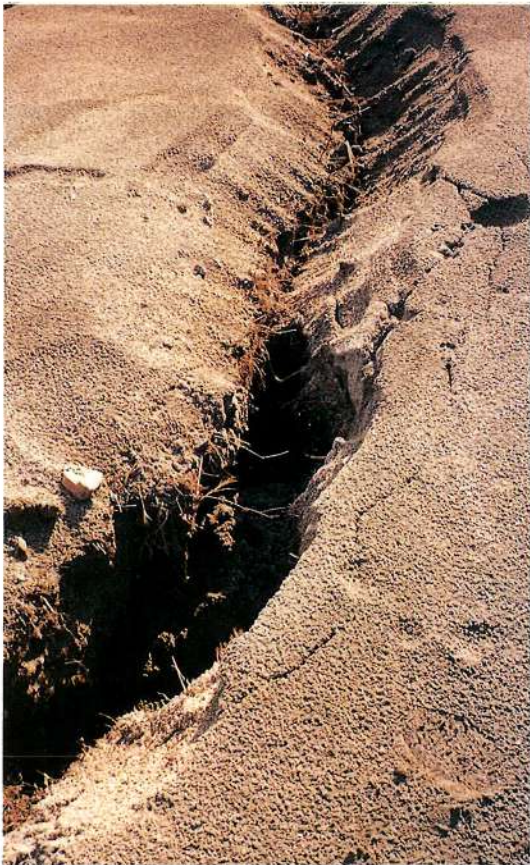
写真(芦-32) 地割れと噴砂<新浜町>
