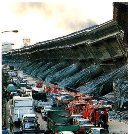
倒壊した阪神高速道路 (写真提供：共同通信社)
