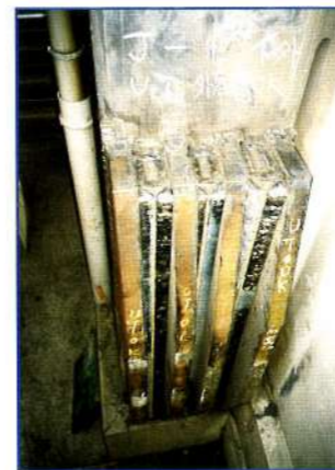
主柱鉄骨の破断部の補強プレート取付直後
