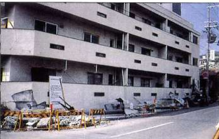
1F店舗部分崩壊
