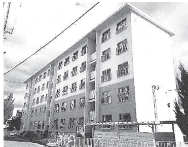
モデル事業が実施されている神戸市西区の伊川谷団地
